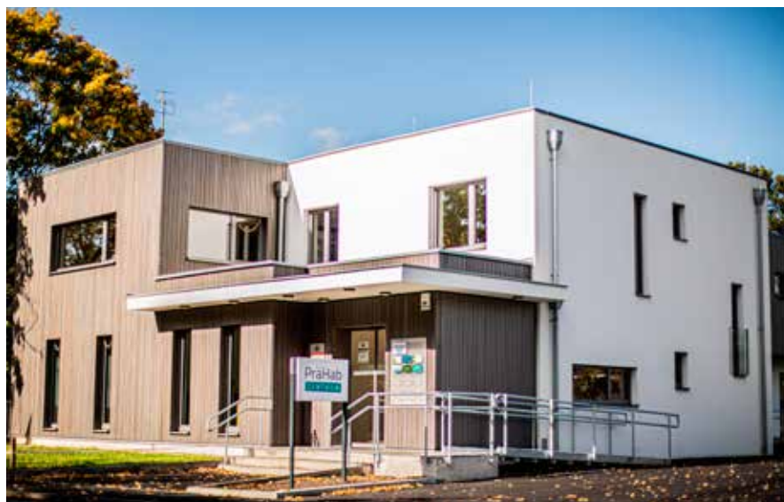
Das neue PräHab-Zentrum Breitenfurt an der Hauptstraße, neben der Polizei
